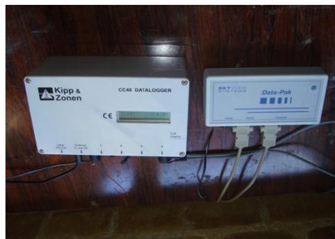
Figure 3 : (a) Pyranomètre (b) Système d'acquisition du Pyranomètre CC 48 KIPP&ZONEN
